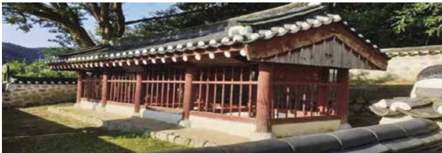
횡성 공근면의 ‘육절려’ 외부 전경
